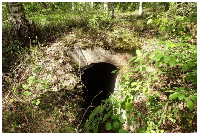
Betonirakenteen eteläinen suuaukko.
